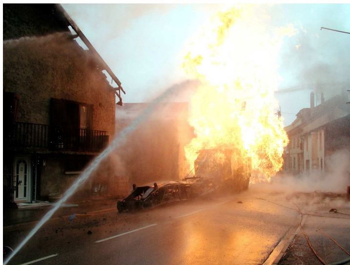
Incendie suite à l'endommagement d'une canalisation de distribution de gaz par une raboteuse de chaussée
